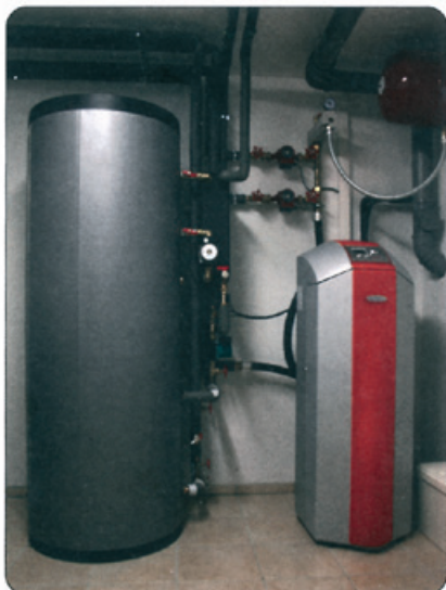
Eine Wärmepumpe von Heliotherm mit Frischwassersystem zur Warmwasseraufbereitung
