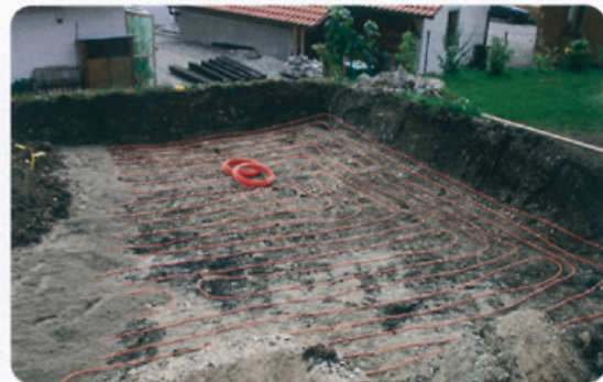
Verlegen und Einsanden eines Erdkollektors mit mehreren Kreisen PE ummantelten Kupferrohrs.
