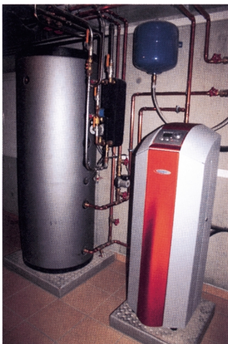
Heliotherm: Wärmepumpe mit Direktverdampfung
