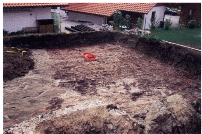
Kollektor: Erdkollektor mit kunststoffummantelten Kupferrohren
